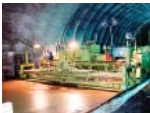
裏白トンネルコンクリート舗装
