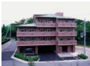
ライラック 新築工事
