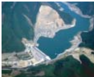
青土ダム建設工事
